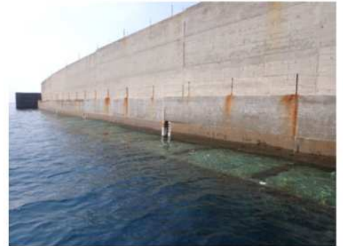
写真 - 1 人工タイドプールの全景
