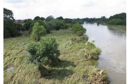
写真-1.流下能力を阻害する河道内樹
