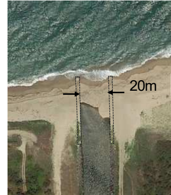
図1 : 北条川放水路河口
